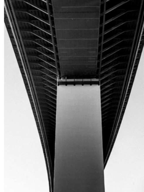
Ungewohnte Perspektive: die Mintarder Ruhrthalbrücke, mit 1.830 Metern längste deutsche Stahl-Straßenbrücke
