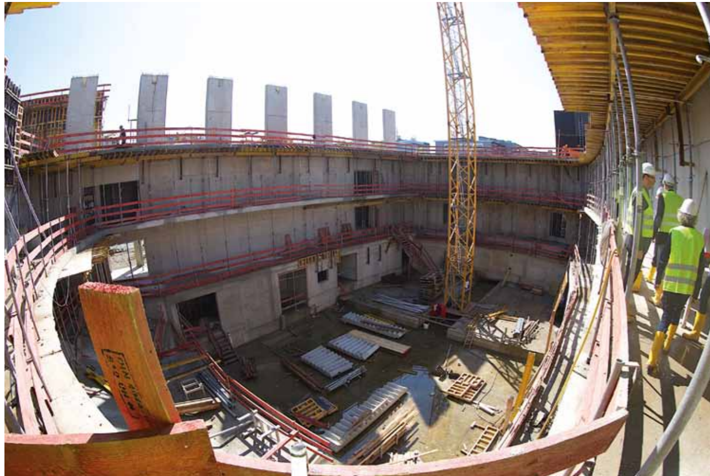
Auf der Baustelle im Sommer 2014: Der spätere Konzertsaal im Rohbau.
